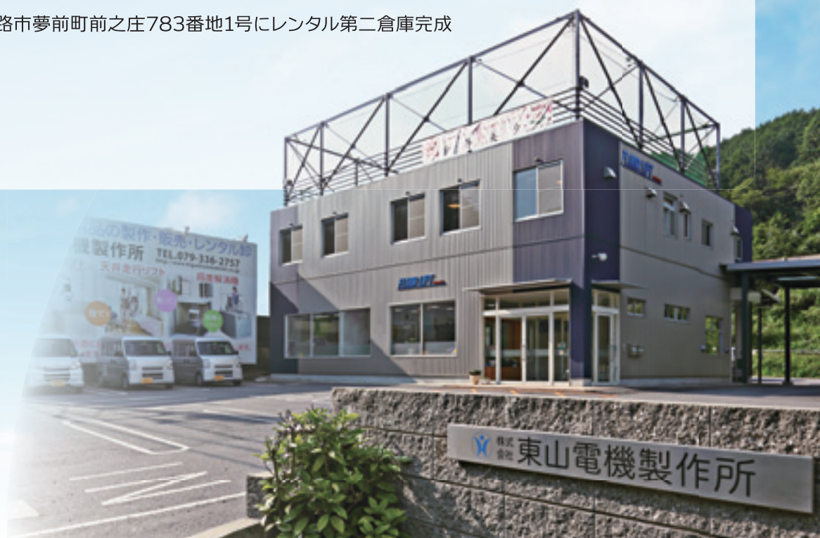
株式会社東山電機製作所 本社
